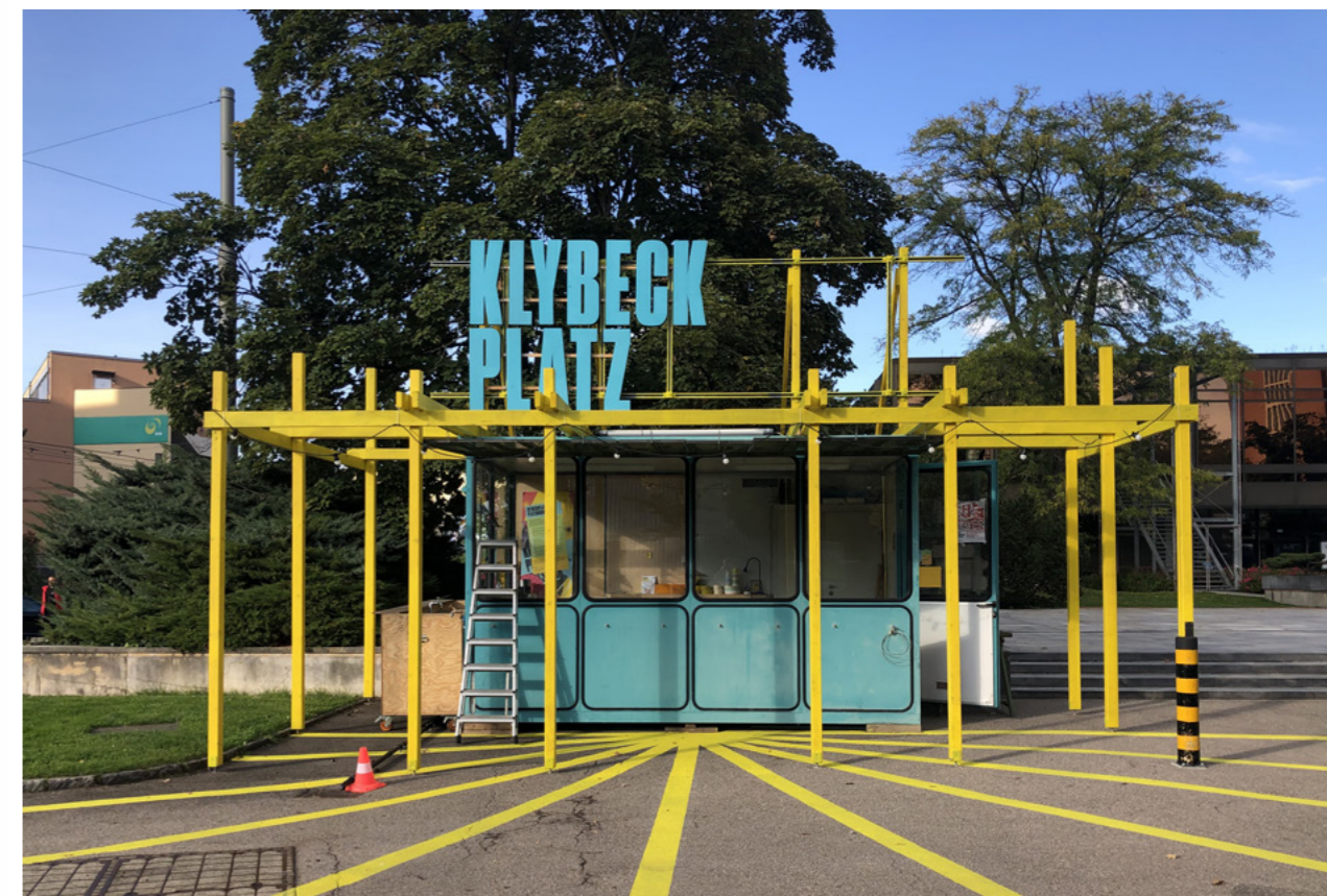
↑ Betriebszentrale Klybeckplatz, Sommer 2021
